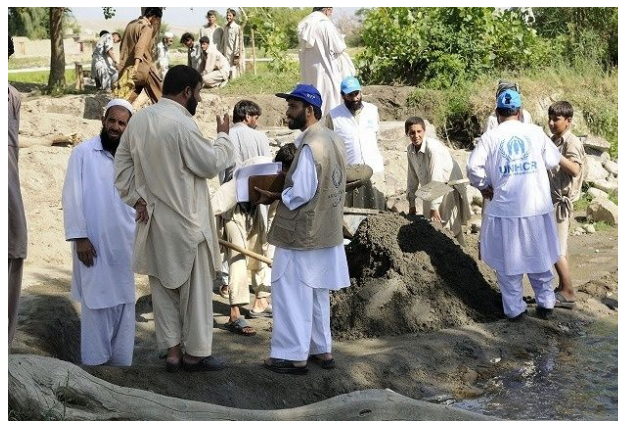
灌漑施設の建設
